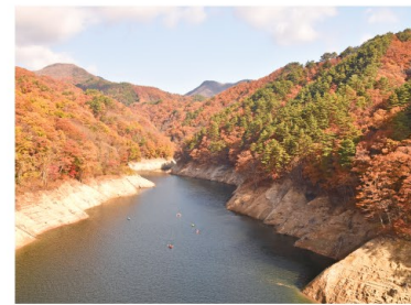
摺上川ダム管理所
